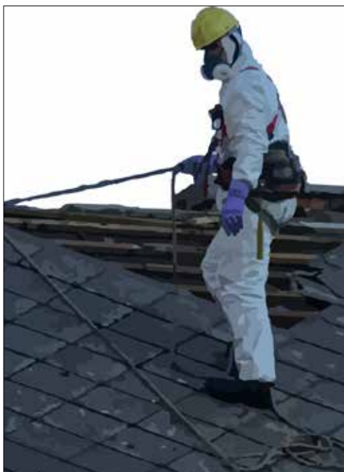
Slika 18: Uporaba osebne varovalne opreme pri odstranjevanju cement-azbestne kritine
